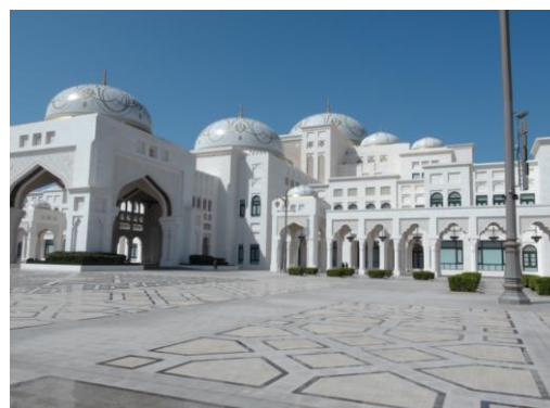
Vstup na prohlídku.
